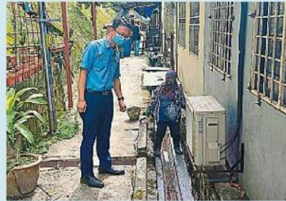
陈狄源表示沟渠因排水水平线倒流状态，无法顺利排水造成雨后积水。(李景志摄)
